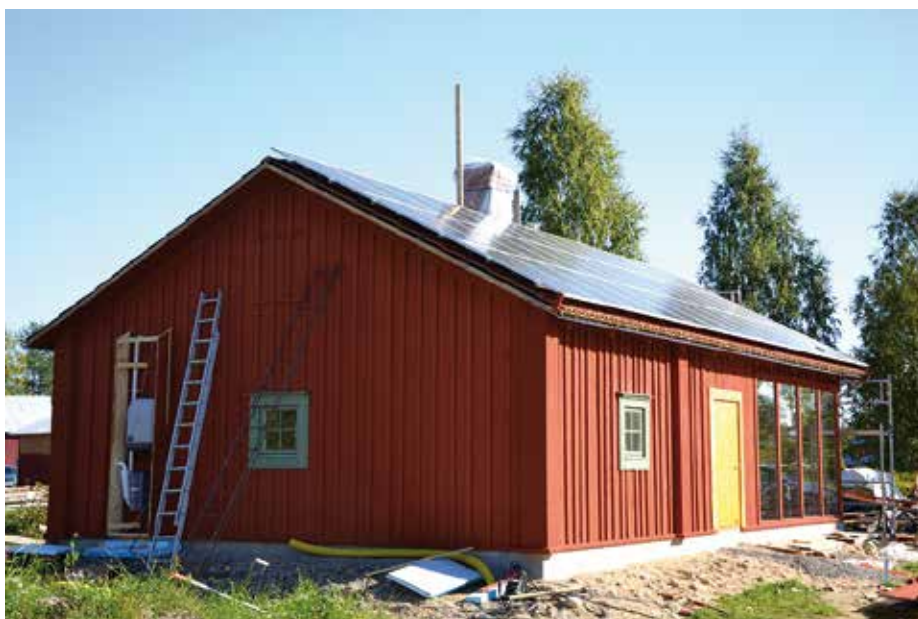
Huset från utsidan med solpaneler på taket. Foto: Sofia Tjärnström
